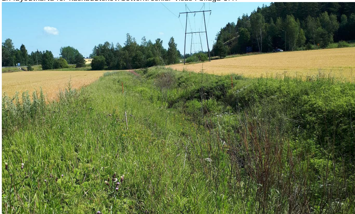
Bild 1. Stamdike som rinner från Malmkullahället. I nuläget hålls fåran inte öppen under lågvattenflöde, trots fårans branta lutning.
