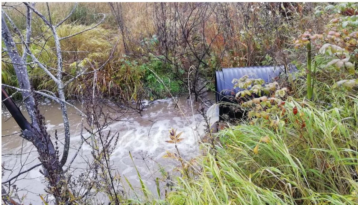
Bild 2. Rörläggning i Duschbäcken (bild Minttu Peuraniemi)
