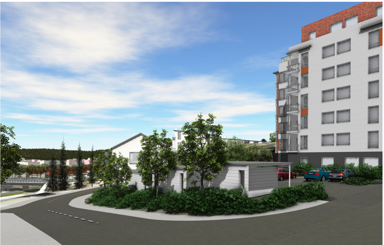
Vy från Kilavägen mot nordost. Näkymä Kilantieltä koilliseen.
