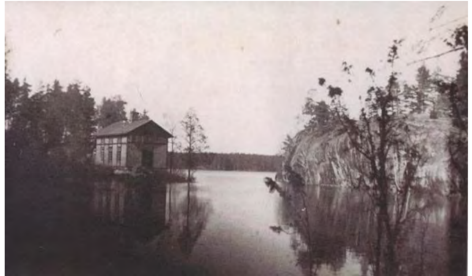
Vid inventering från 1864 upptas en ny byk- och kokstuga av tegel. Bygganden som kallades Stenbyggningen låg vid Degergårdsträsket. Byggnaden har senare rivits och omgivningen har förändrats efter att dammen revs. (Lundqvist 2000/Fiskars arkiv)
