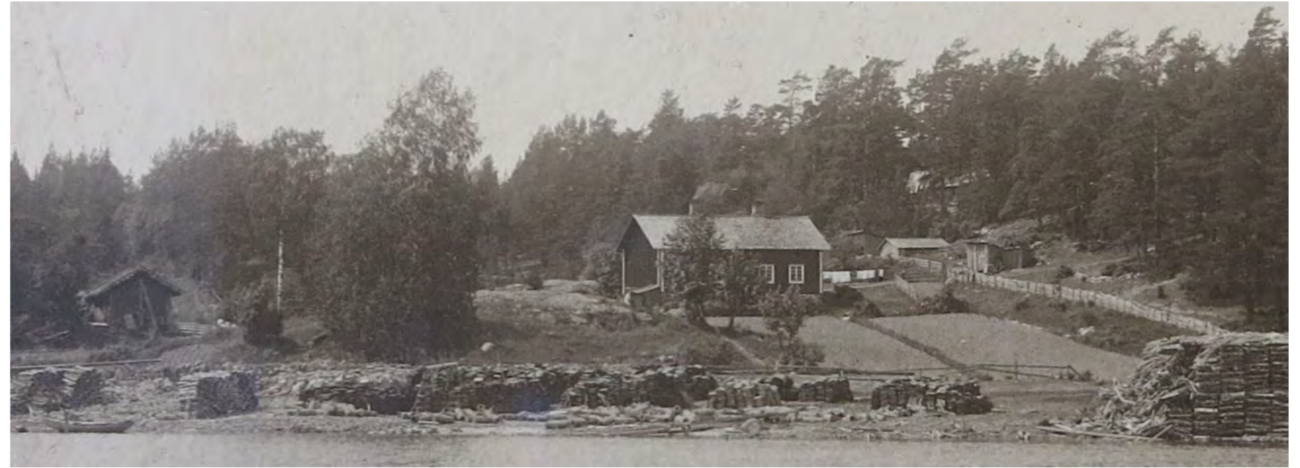
Arbetarbostad Nr II, som kallades Kakola byggdes år 1888. Till vänster syns en gammal stockbod. Delförstoring av fotografi. (Bild S. Renlund)
