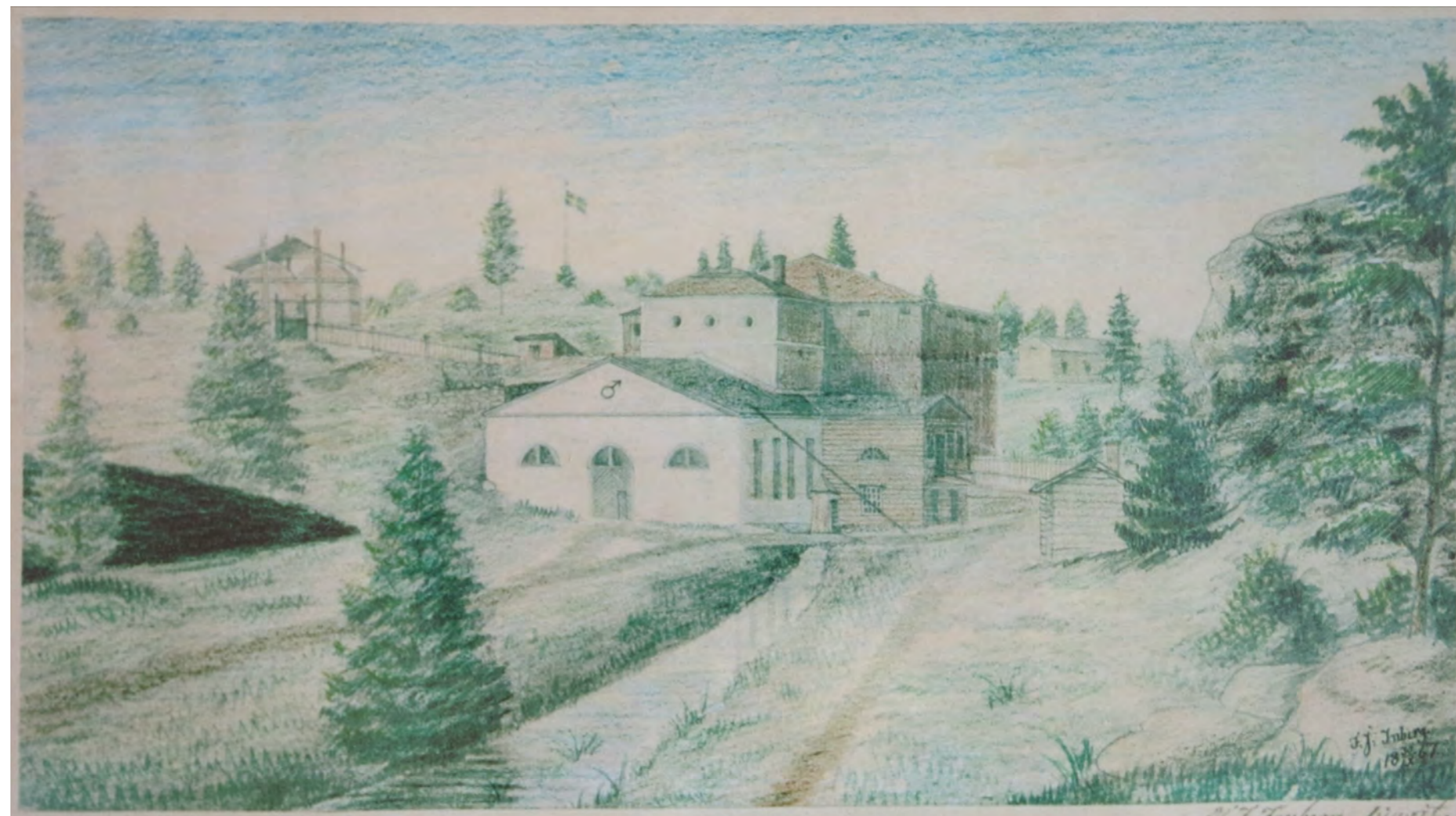
På en tavla från år 1867 kan man i mitten se den stora mångdelade masugnbyggnaden. Till vänster uppe på backen låg den första kolugnsbyggnaden med två ugnar. Tavlan är daterad 30.9.1867 och signerad av K.J. Ingberg. Bild S. Renlund.
