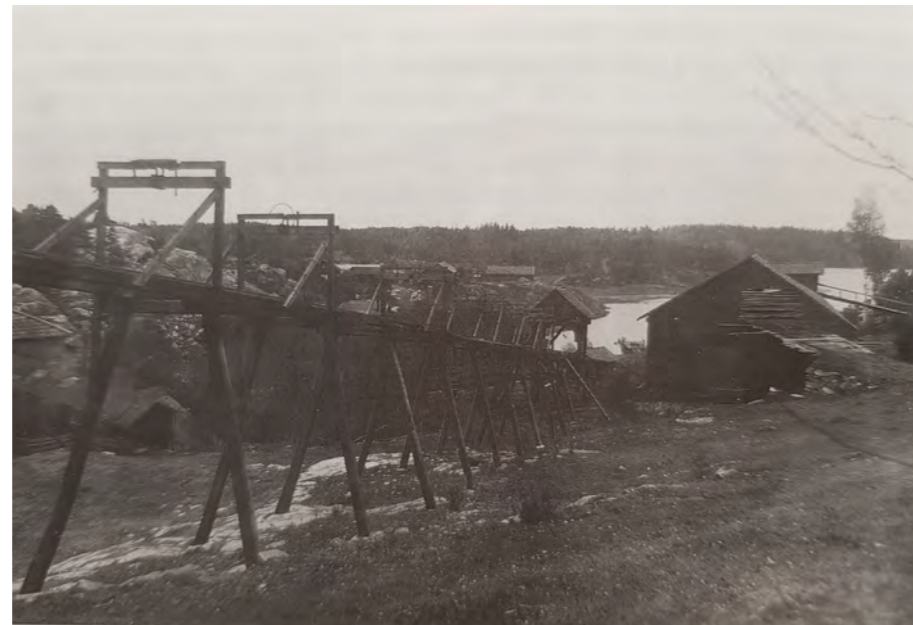
För eldandet i masugnen behövdes kol, som tillverkades i kolugnar eller sk. kolmilor. De för området karakteristiska kolmilorna byggdes i rad längs stränderna nära hamnen. Som bäst fanns det 12 eller 13 kolmilor på området. Till en början byggdes ugnarna av tegel från tegelbruket på Kalvholmen, senare övergick man till att använda slaggtegel. Bilden är tagen vid brukets slutskede, i förgrunden syns den gamla stenbron. Bild S. Renlund.
