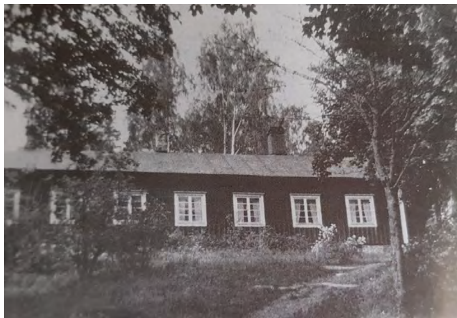
Kontorsbyggnaden (A) som senare kom att bli inspektorsbostad. Bilden är från början av 1900-talet. Hannes Henrichs .GL 2000(s.18)
