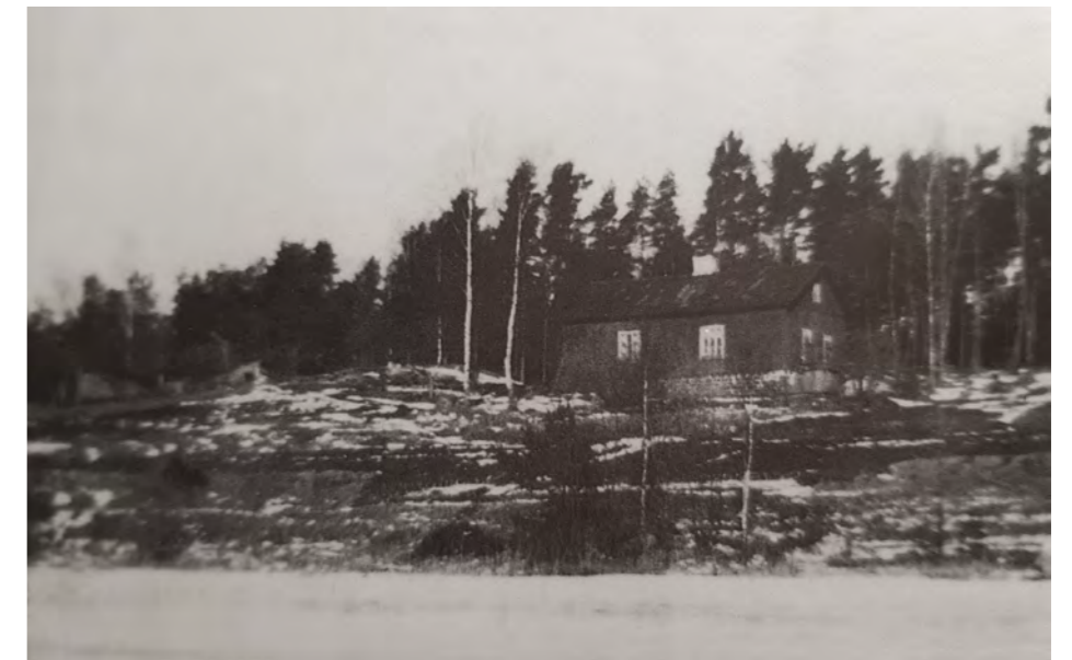
Arbetarbostad byggd 1896, kallad Sibirien, No I, bilden är tagen ca 1930. B. Gröning. Huset som till sina yttre mått var ca 10x20meter, byggdes för 4 familjer. Där fanns 4 spishällar och bakugnar och 12 spjäll. Stock från Trollshovda hemman användes 1393 löpmeter. Huset uppfördes av byggmästare Angelin. Huset hade pärttak och träull användes som isolering i väggarna (72 kg). Namnet Sibirien kom från att huset låg längst ute i kanten av bruksområdet. (Bild S. Renlund)
