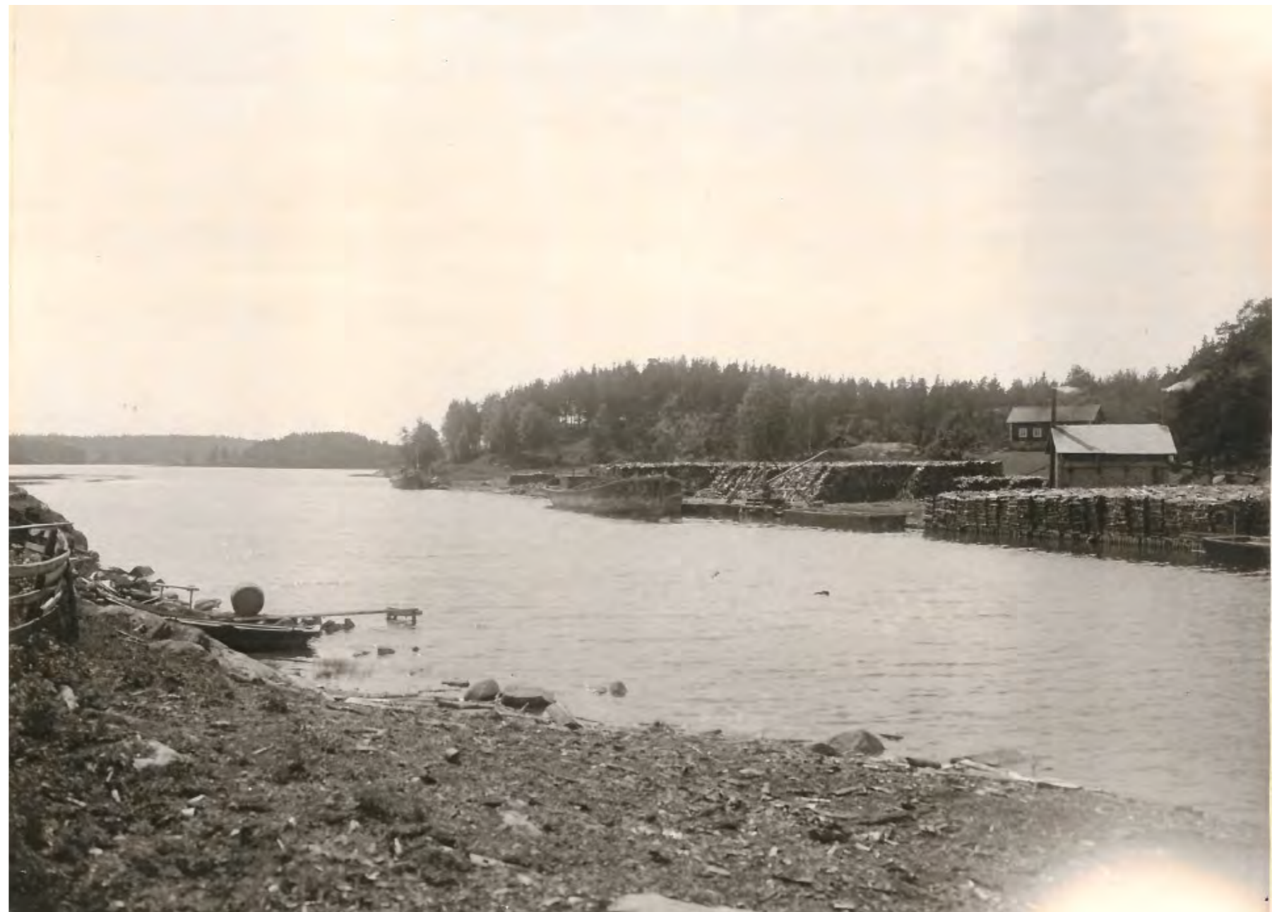
En odaterad bild, antagligen från 1900-talets början. På den motsatta stranden i hamnen ligger radade stora mängder av stock. I bakgrunden syns kolmila nr 12 och bakom denna, den senare rivna arbetarbostaden Kakola. Bild S. Renlund.
