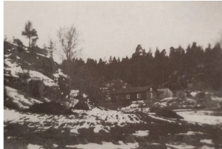
Arbetarbostad No III, byggd 1881. Bilden är tagen ca år 1930. B. Gröning. Byggnaden ersatte en tidigare bostadsbyggnad, möjligen det gamla soldat-torpet ty taktäckningen var av näver. Det nya huset hade pärttak. (Bild S. Renlund)
