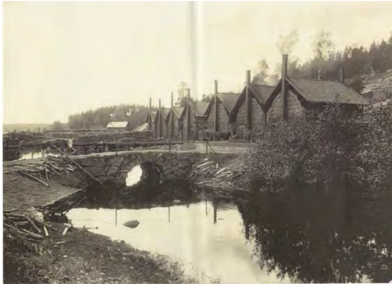
För eldandet i masugnen behövdes kol, som tillverkades i kolugnar eller sk. kolmilor. De för området karakteristiska kolmilorna byggdes i rad längs stränderna nära hamnen. Som bäst fanns det 12 eller 13 kolmilor på området. Till en början byggdes ugnarna av tegel från tegelbruket på Kalvholmen, senare övergick man till att använda slaggtegel. Bilden är tagen vid brukets slutskede, i förgrunden syns den gamla stenbron. Bild S. Renlund.
