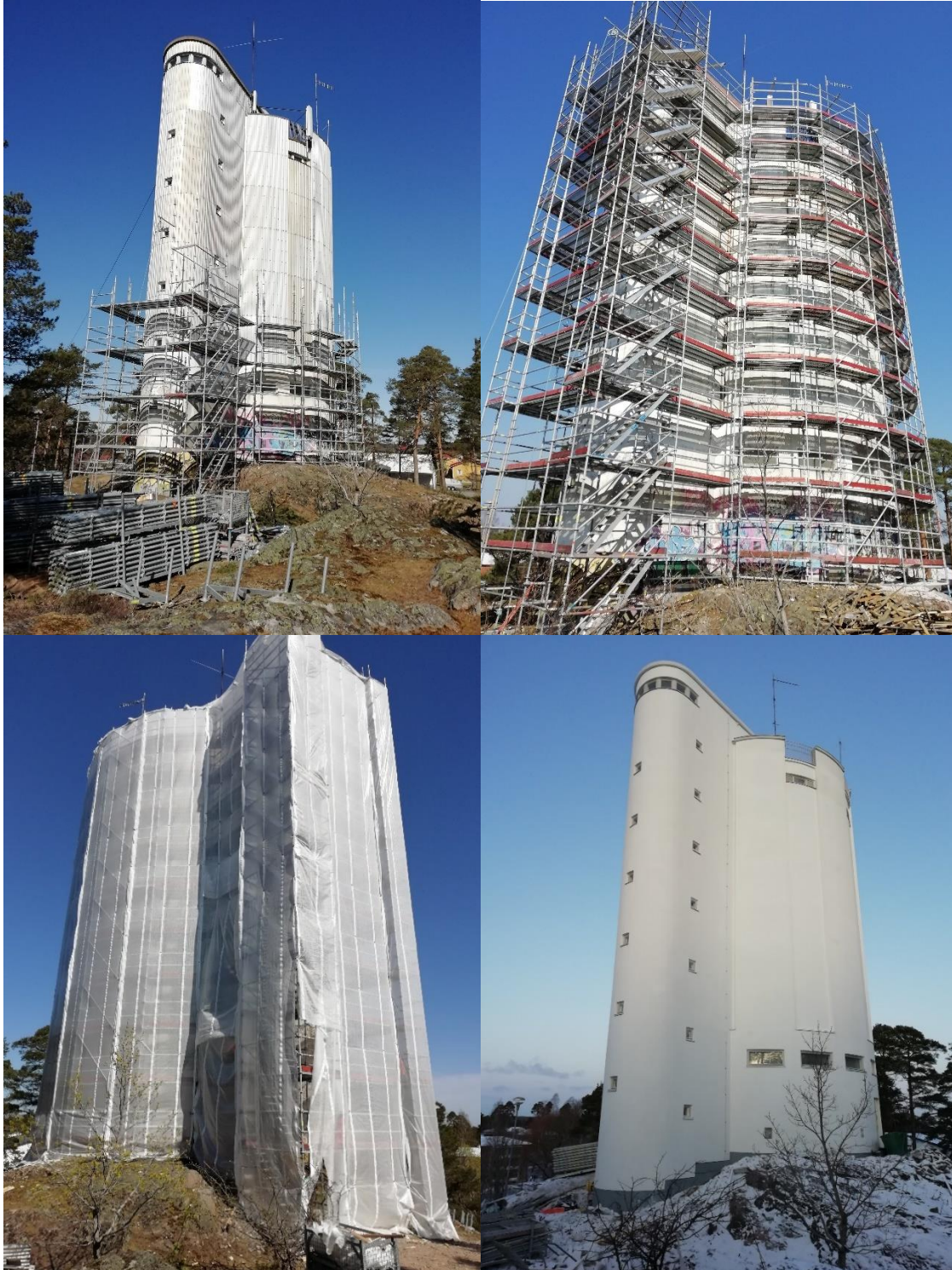
Karis vattentorn i olika skeden av saneringen, 2019.
