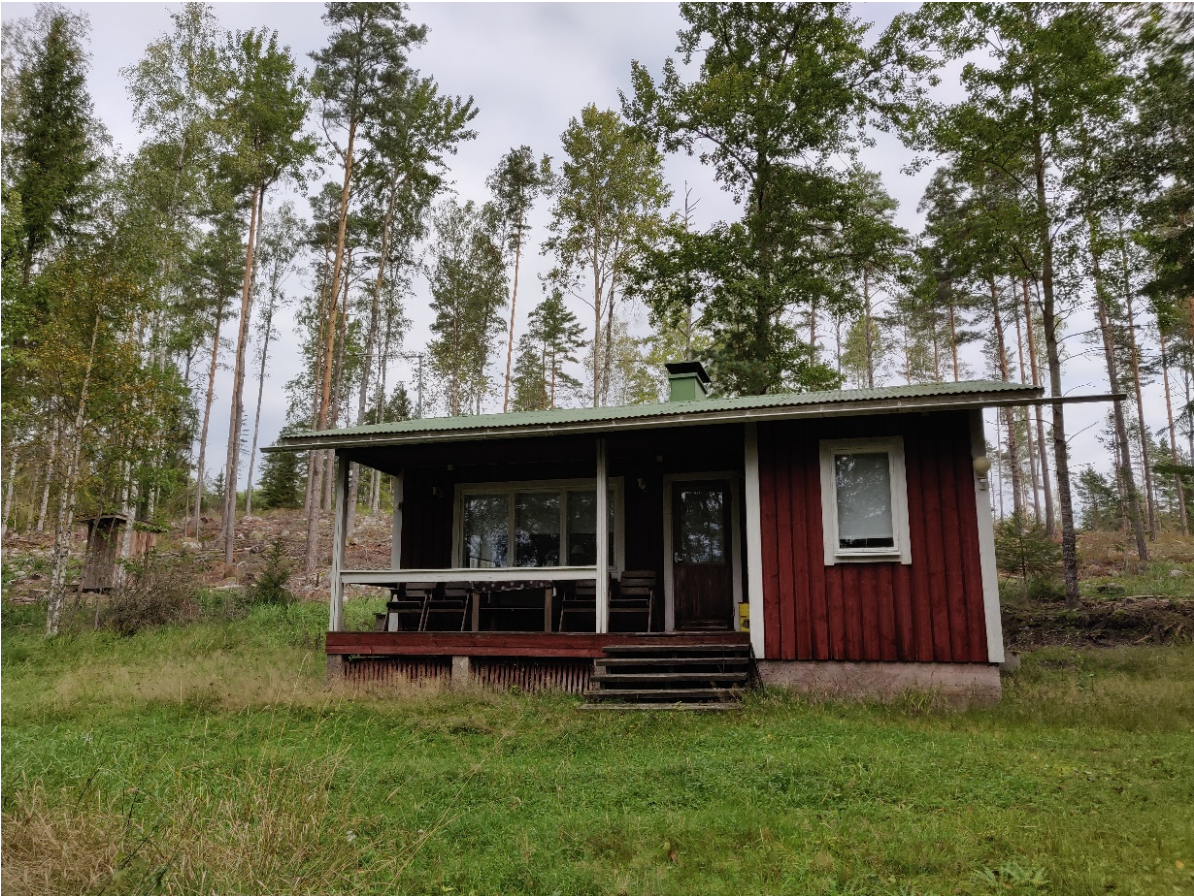
Kuva 5 Kettulan pääjulkisivu (etelä/lounaaseen).
