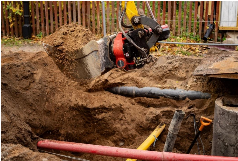
Bild 3 Kommunalteknik vid Linväwaregatan, Ekenäs
