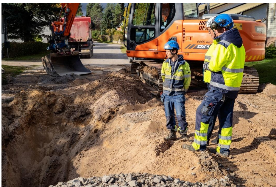
Bild 1 Jonny, Guy, Robert och sanering av ledningar, Domaregatan, Karis
