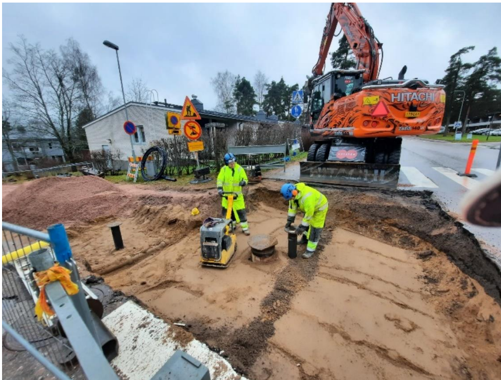
Bild 4 Jussi och René och sanering av ledningar, Klockarsgatan, Karis
