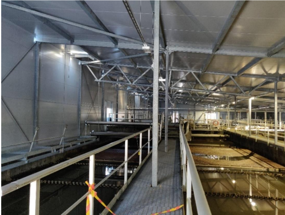
Bild 5 Byggandet av väggar och tak vid Skeppsholmens reningsverk närmar sig slutskedet
