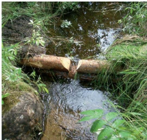
Kuva 3-3. Puinen pohjakynnys ja virtaa ohjaavat suisteet. (Ympäristöopas 2008, Purokunnostusopas).
