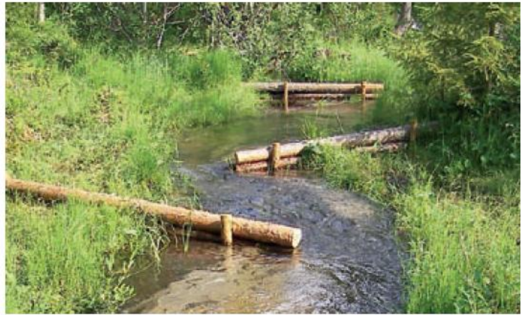
Kuva 3-3. Puinen pohjakynnys ja virtaa ohjaavat suisteet. (Ympäristöopas 2008, Purokunnostusopas).
