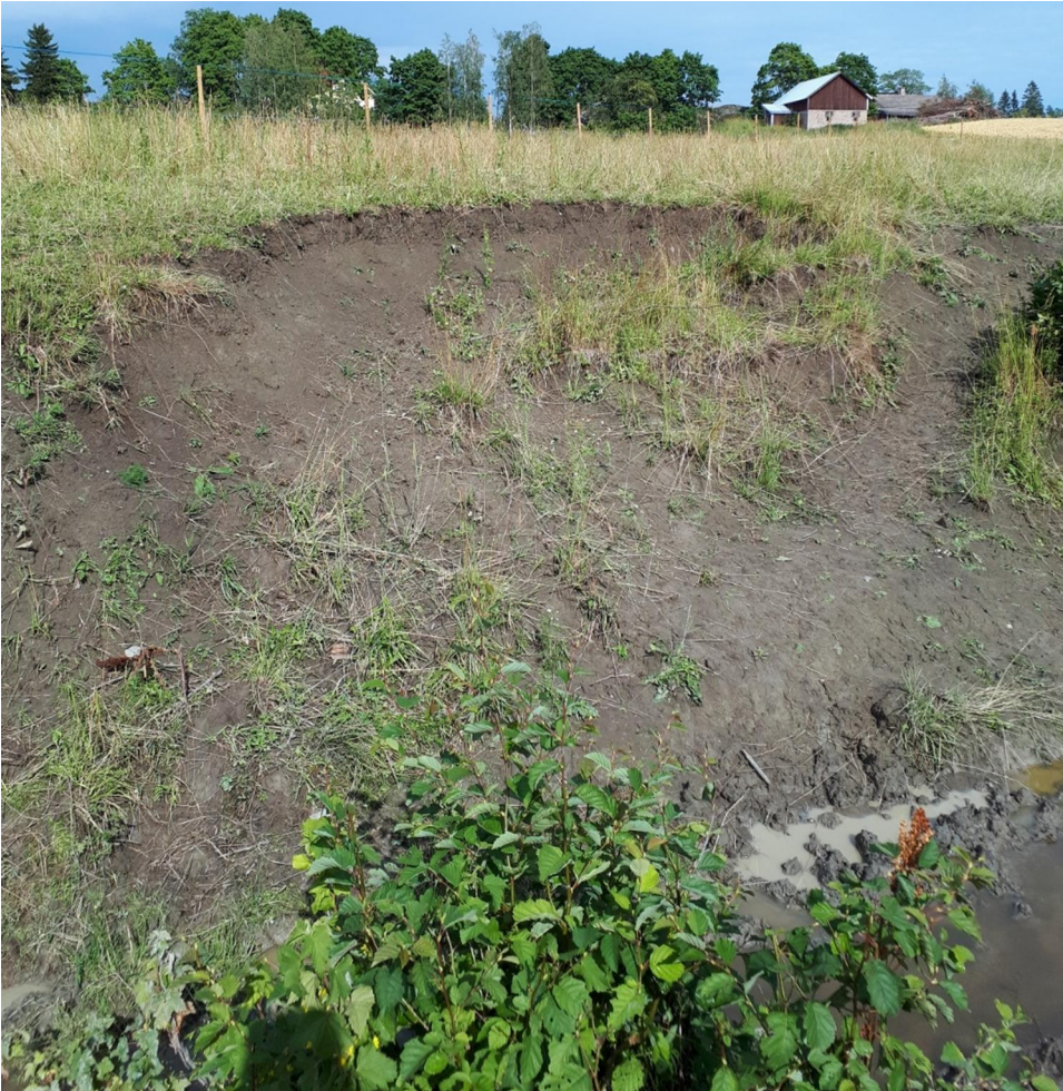
Kuva 4. Tuore luiskasortuma. Luiskat tulisi verhoilla esim. louheella, jolloin niiden stabiliteetti paranisi.
