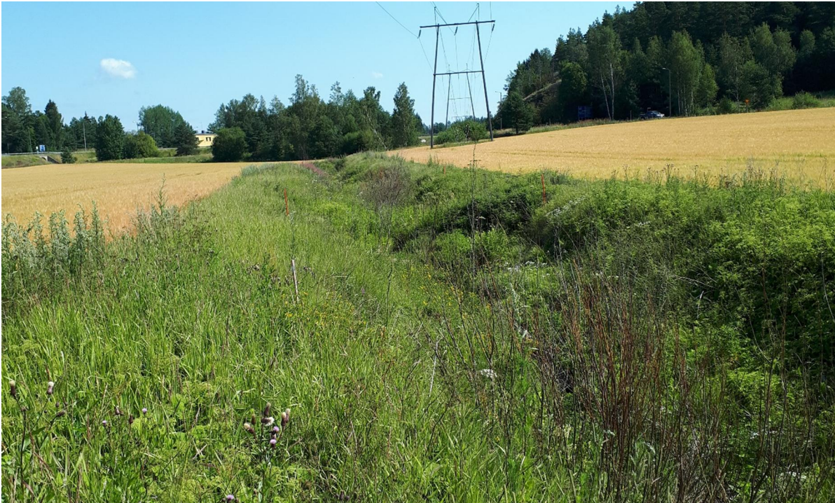
Kuva 1. Malmkullan suunnasta laskeva valtaoja. Nykyisellään alivirtaamat ei pysty pitämään uomaa auki jyrkästä pituuskaltevuudesta huolimatta.
