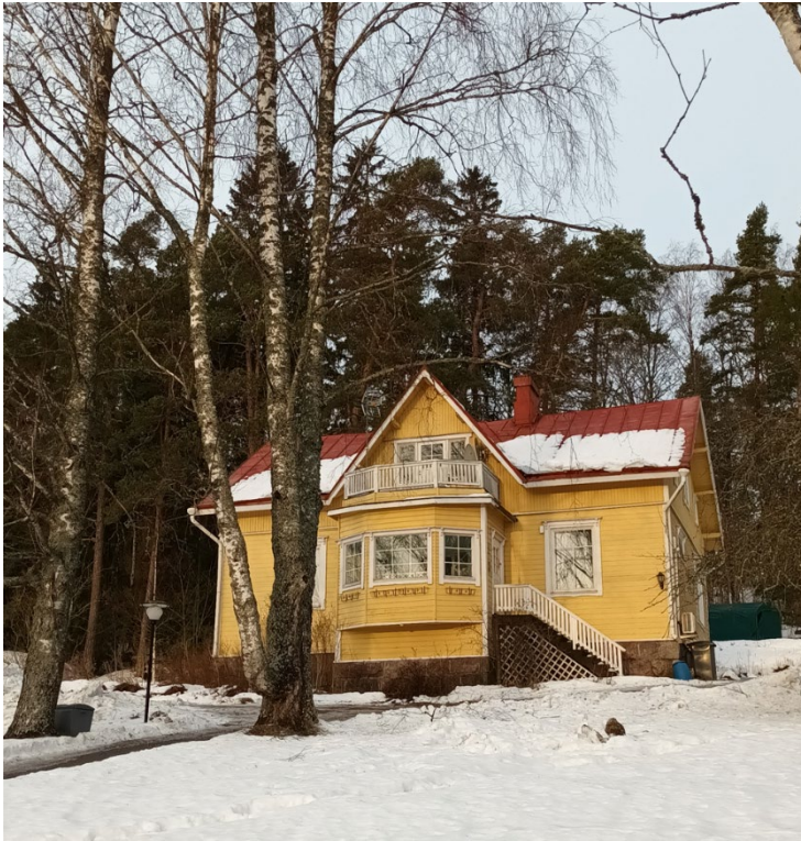
Kuva 6. Vanha Turuntie 95, talo on rakennettu 1910–1920-luvulla. Ikkunat ovat osittain uusittu, laudoitus on muutettu ja itäpäädyn sokkeli on muutettu. Talolla on vanha palapeltikatto.
