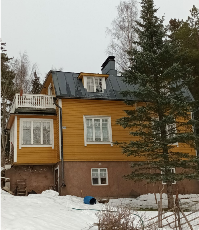
Kuva 10. Vanha Turuntie 103, talo on rakennettu 1920–1930-luvulla. Talossa on vanhat ikkunat mutta joitakin ikkunalaseja on uusittu.
