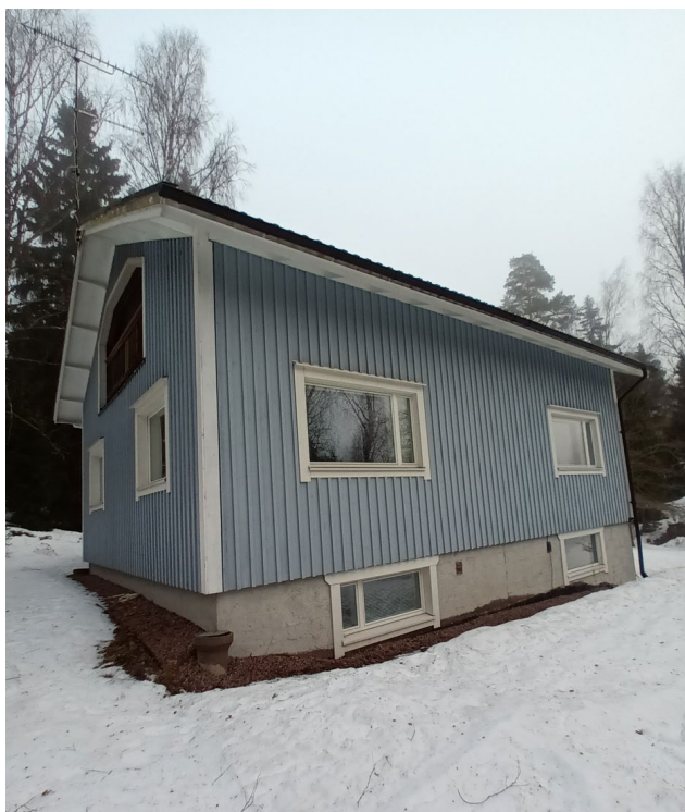
Bild 13. Gamla Åbovägen 109, huset byggt på 1950–1960-talet. Fönstren förnyade, ny brädfodring med tilläggsisolering och taket förnyat.
