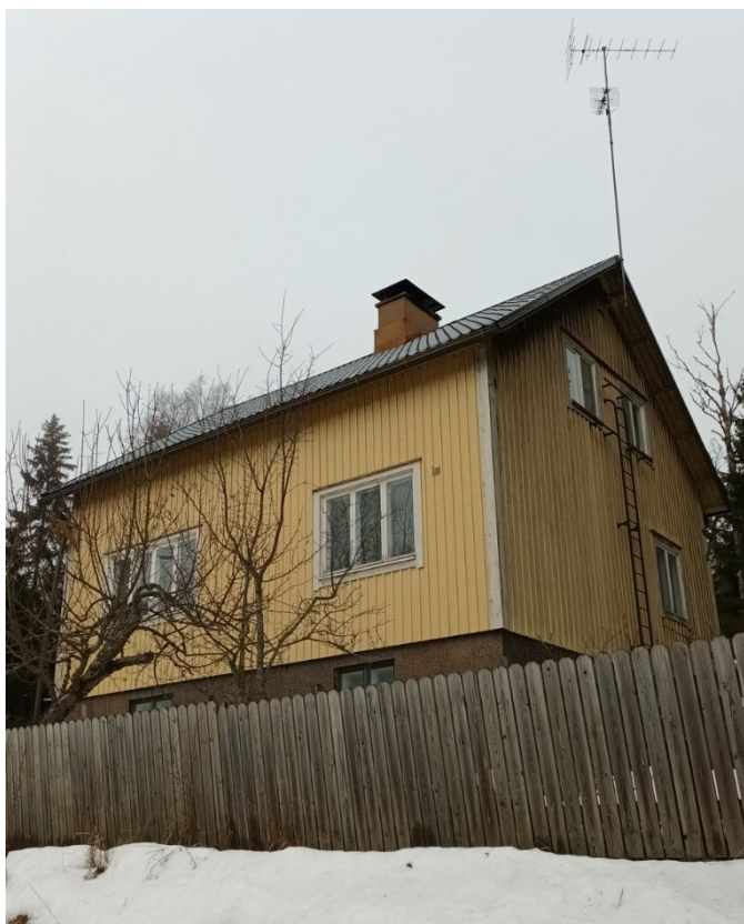
Bild 12. Gamla Åbovägen 107, huset byggt på 1940–1950-talet. En del av fönstren förnyade, taket förnyat och ett takburspråk på husets norra sida byggt efter 1995. Brädfodringen troligen i ursprunglig form.
