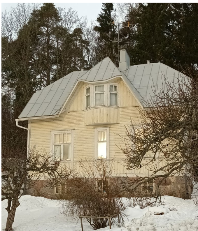
Bild 7. Gamla Åbovägen 97, huset byggt på 1910–1920-talet. Gammal brädfodring och gammalt plåttak. Fönstren huvudsakligen gamla.
