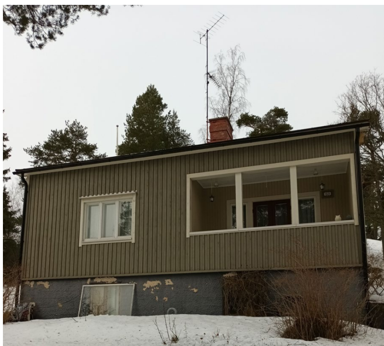
Bild 9. Gamla Åbovägen 101, huset byggt på 1930-talet. Fönstren förnyade. Gammalt plåttak.
