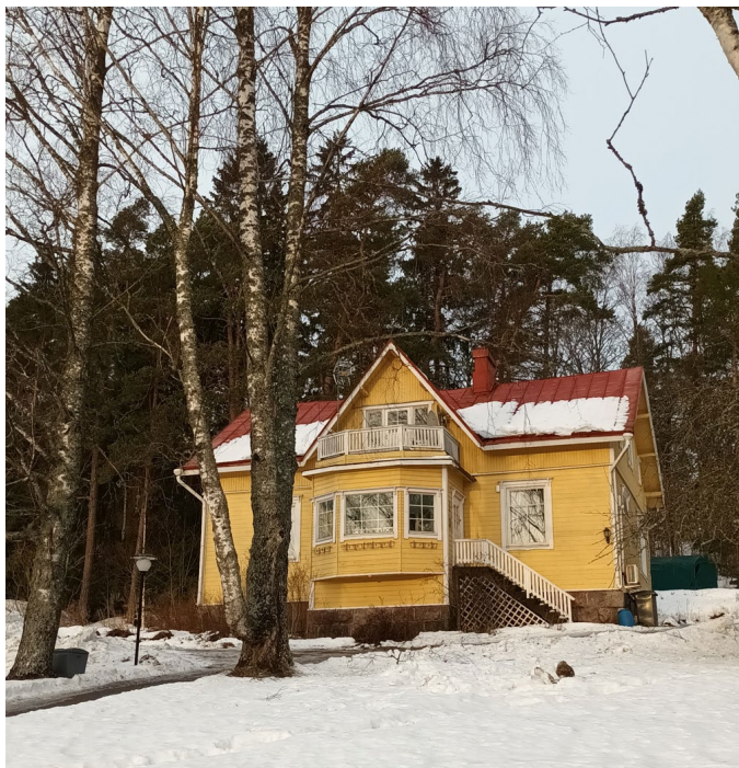
Bild 6. Gamla Åbovägen 95, huset byggt på 1910–1920-talet. Fönstren är delvis förnyade, brädfodringen ändrad och sockeln har på den östra gaveln ändrats. Huset har gammalt plåttak.
