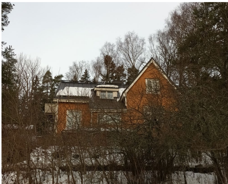
Bild 8. Gamla Åbovägen 99, huset byggt på 1910–1920-talet. Huset har eventuellt flyttats till sin nuvarande plats från Terijoki 1924. En del av fönstren är förnyade. Taket förnyat 2019. Brädfodringen förnyad. Husets östra del har byggts till.
