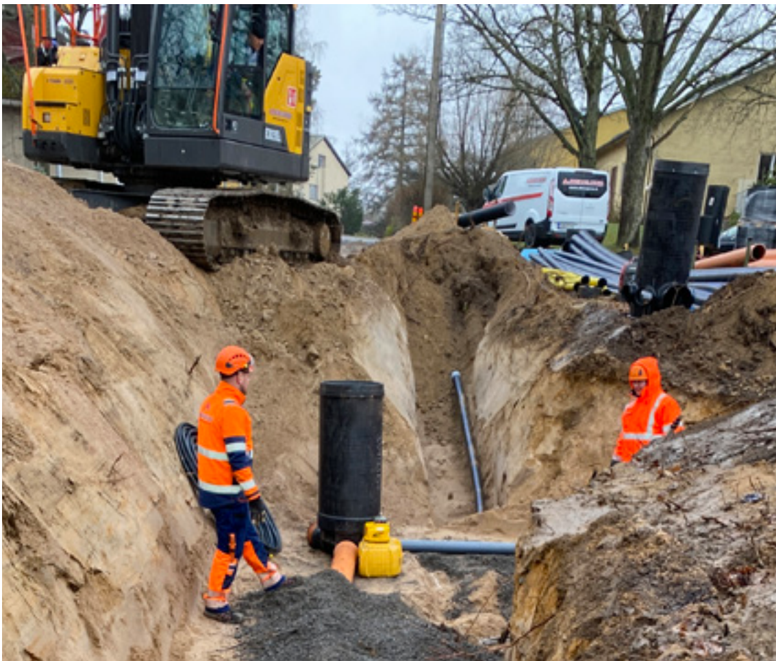
Saneringsarbete på Stabsgatan | Foto: Mats Gerkman
