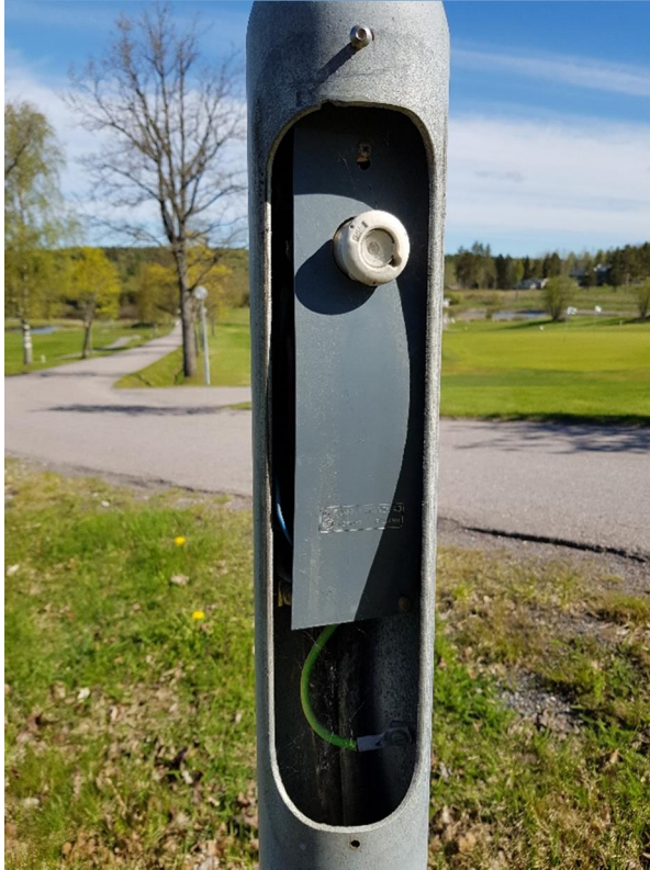
Kuva 6. Pylvään kytkentätila
