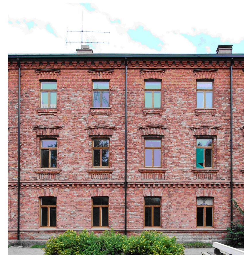
Figur 9. Typisk fasad på en befintlig byggnad på området.
