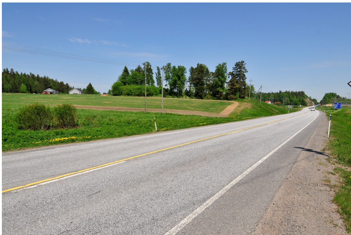
Harjula. Objektet ligger på backen i mitten av bilden. Strax söder om den går Hangövägen. Fotograferat från sydväst. (AKDG3175:1)
